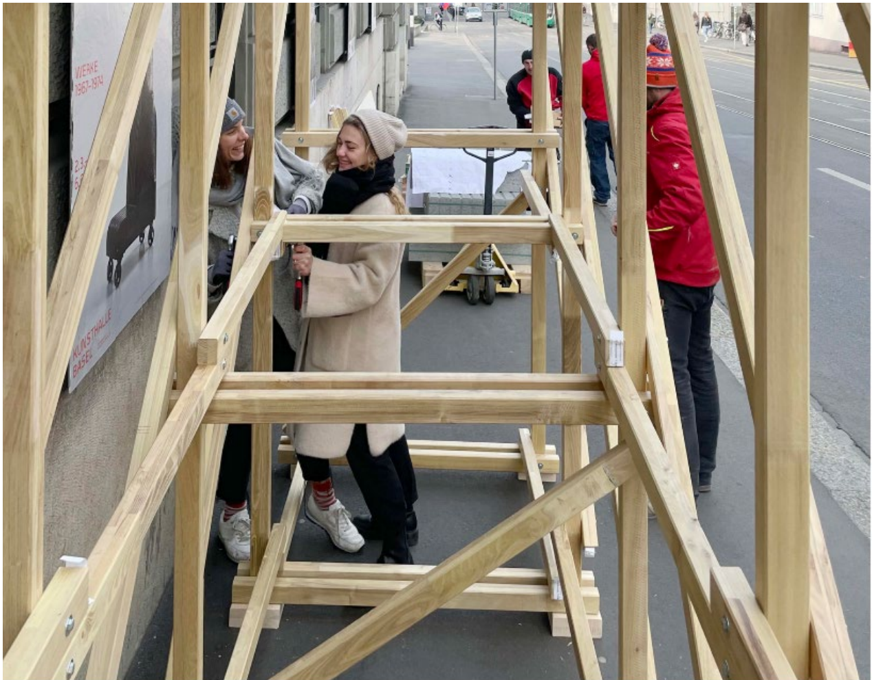
Studierende des Bachelors in Architektur helfen beim Aufbau des neuen Zugangs zum Schweizerischen Architekturmuseum.
