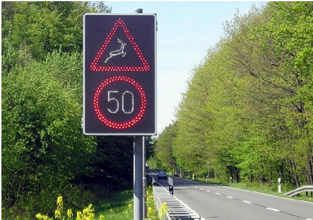
Bild: Signalisation einer Wildwarnanlage
