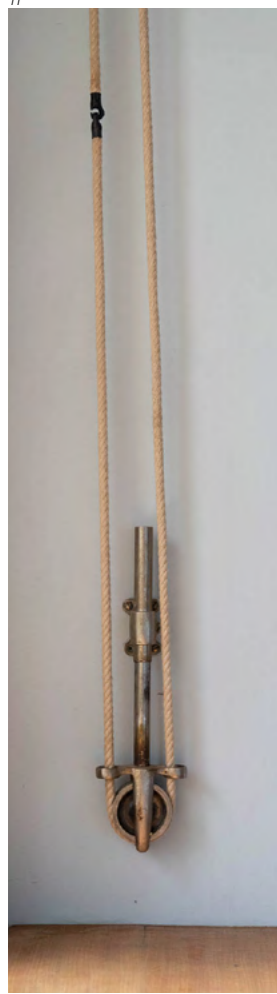
Abb. 11 Detail des Seilantriebs der originalen Holzlamellenroll- läden, nach der Restaurierung.
