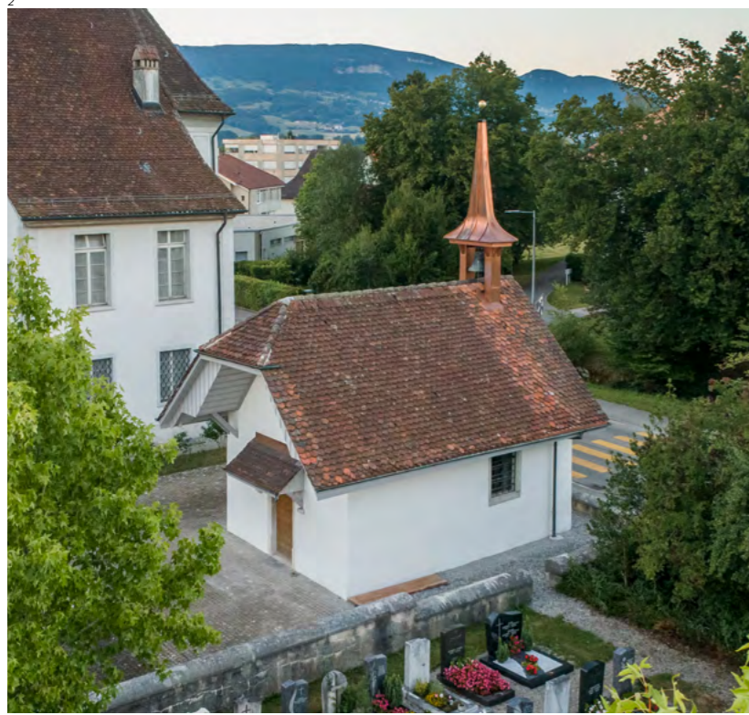
Abb. 2 Die Kapelle im Zustand nach der Restaurierung 2020. Ersetzt wurden der gesamte Aussenverputz und der kupferverkleidete Dachreiter.
