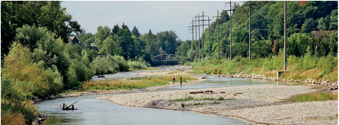
Emme, Blick Fluss aufwärts Richtung Bogenbrücke Gerlafingen.
