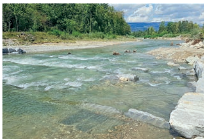
Die neue Riegel-Becken-Rampe stellt den Fischaufstieg sicher.
