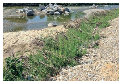
Weidenstecklinge lassen das Ufer in Kürze grün werden.
