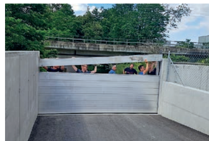
Hochwasserschutzmauern und mobile Elemente schützen die Untere Emmengasse in Luterbach.
