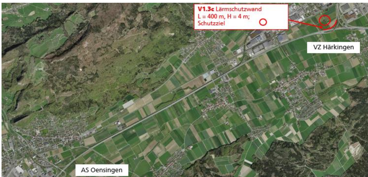
Abbildung 8: Neubau Lärmschutzwand Neuendorf Nord (V1.3c)
