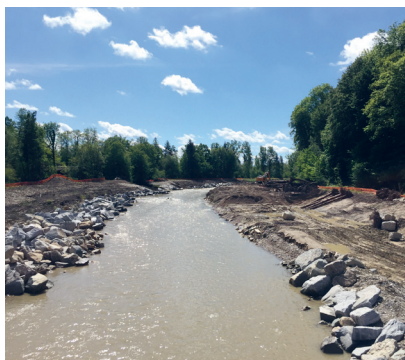
Bauphase am Dittiberg
