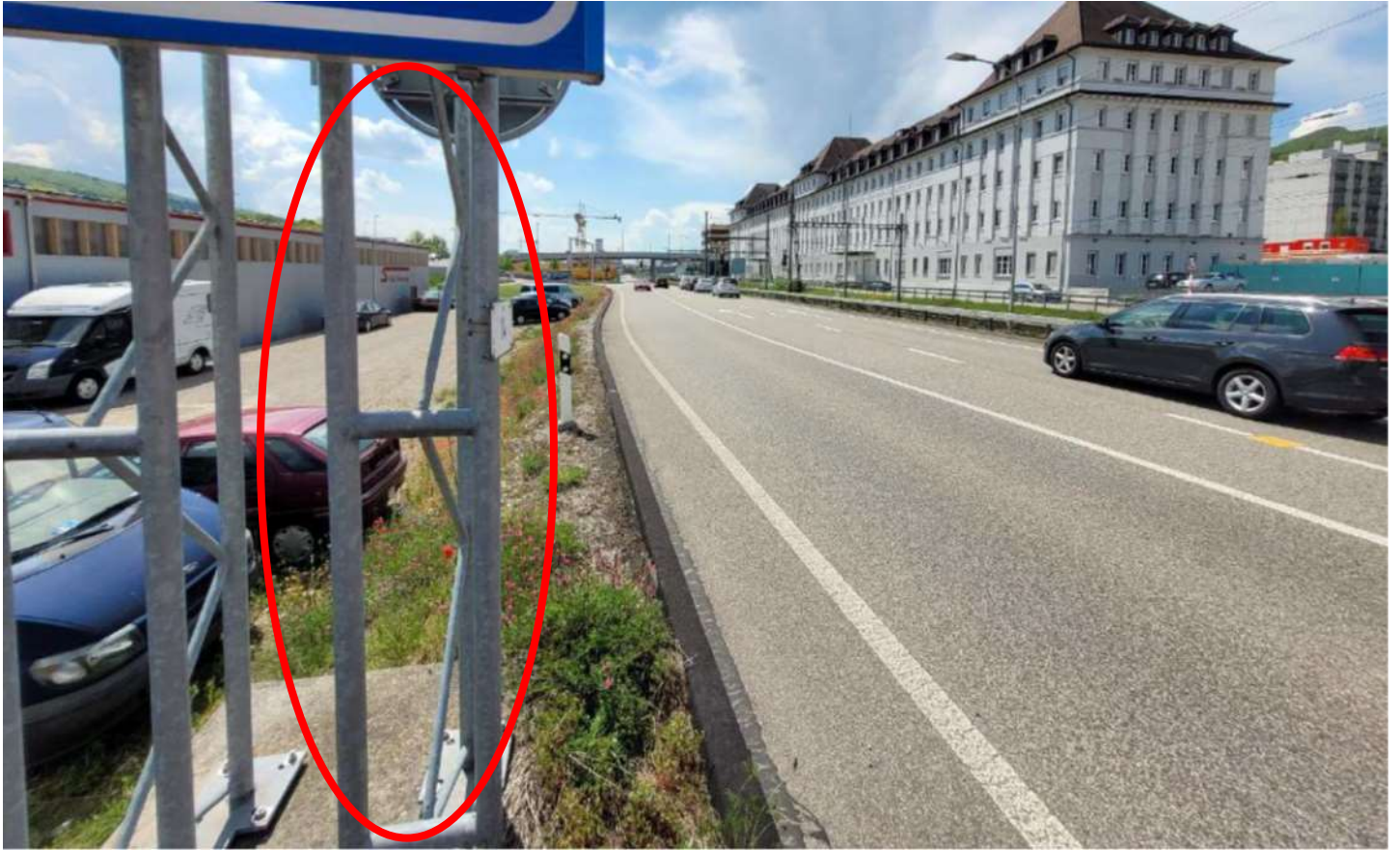
Standort 1 | 47.3479486, 7.890683; Ri Olten, Rohrschelle, Akkubetrieb; Pelicase; Kabel lang
