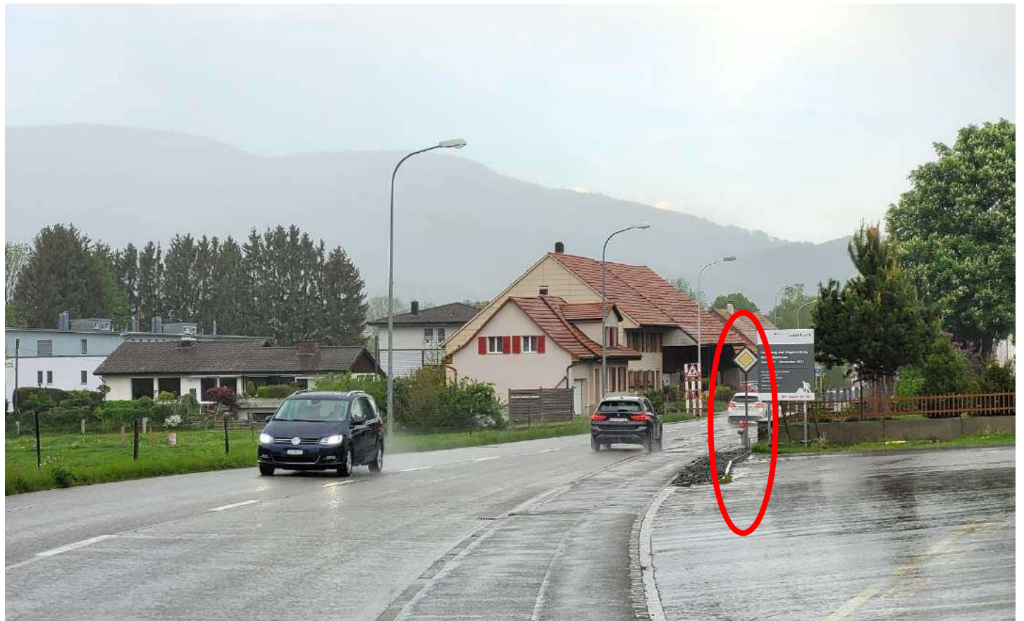
Ri Gunzgen, Rohrschelle Signal Hauptstr., Akkubetrieb; Kabel lang
