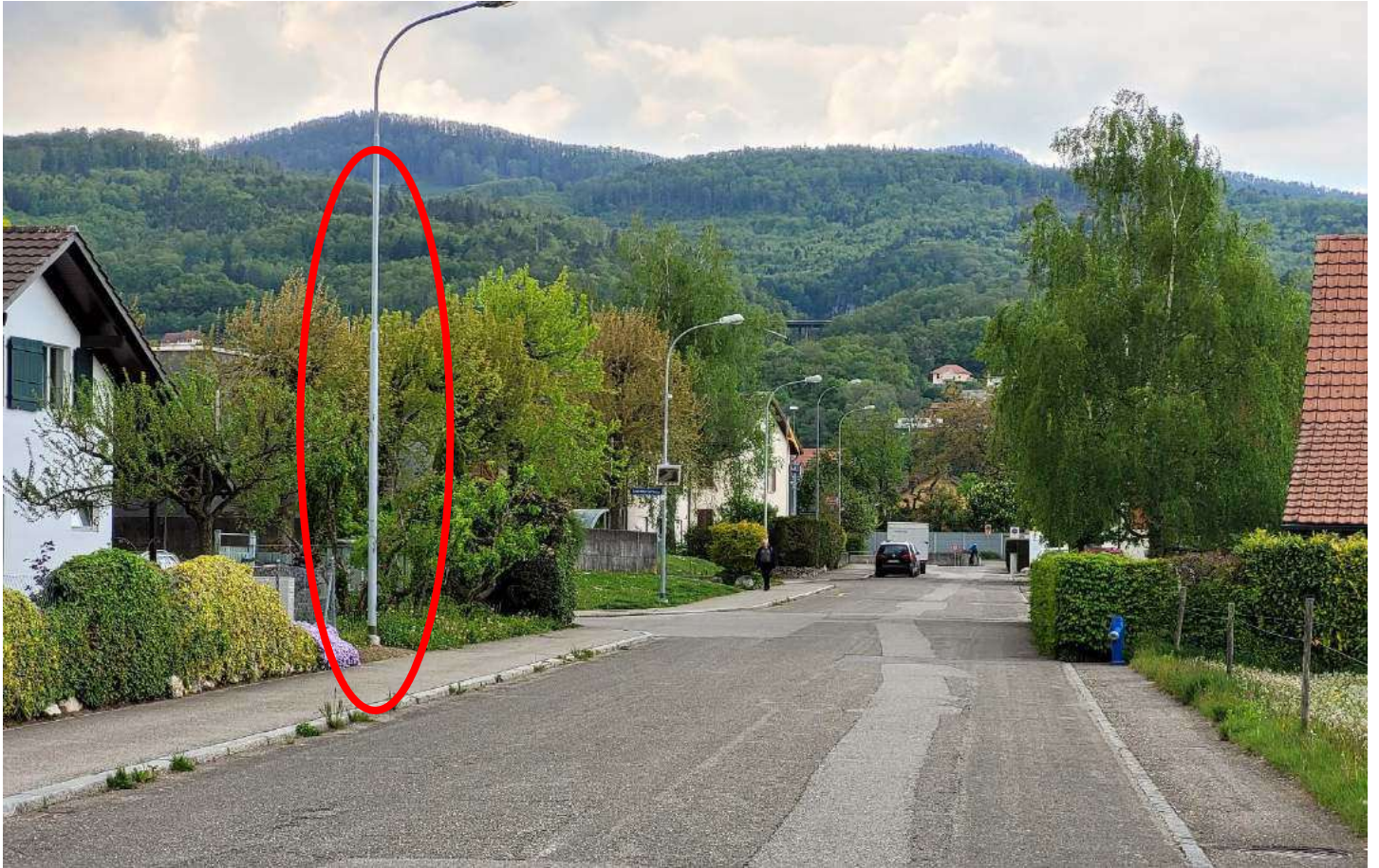
Standort 14 | 47.3295064, 7.8482334; Ri Kappel, Kandelaber, Nachtstrom; Bigbox; Kabel kurz
