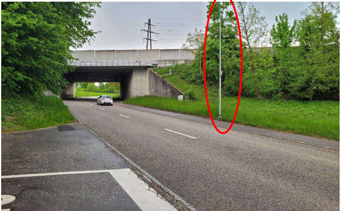
Ri Kappel, Kandelaber, Nachtstrom; Bigbox; Kabel kurz
