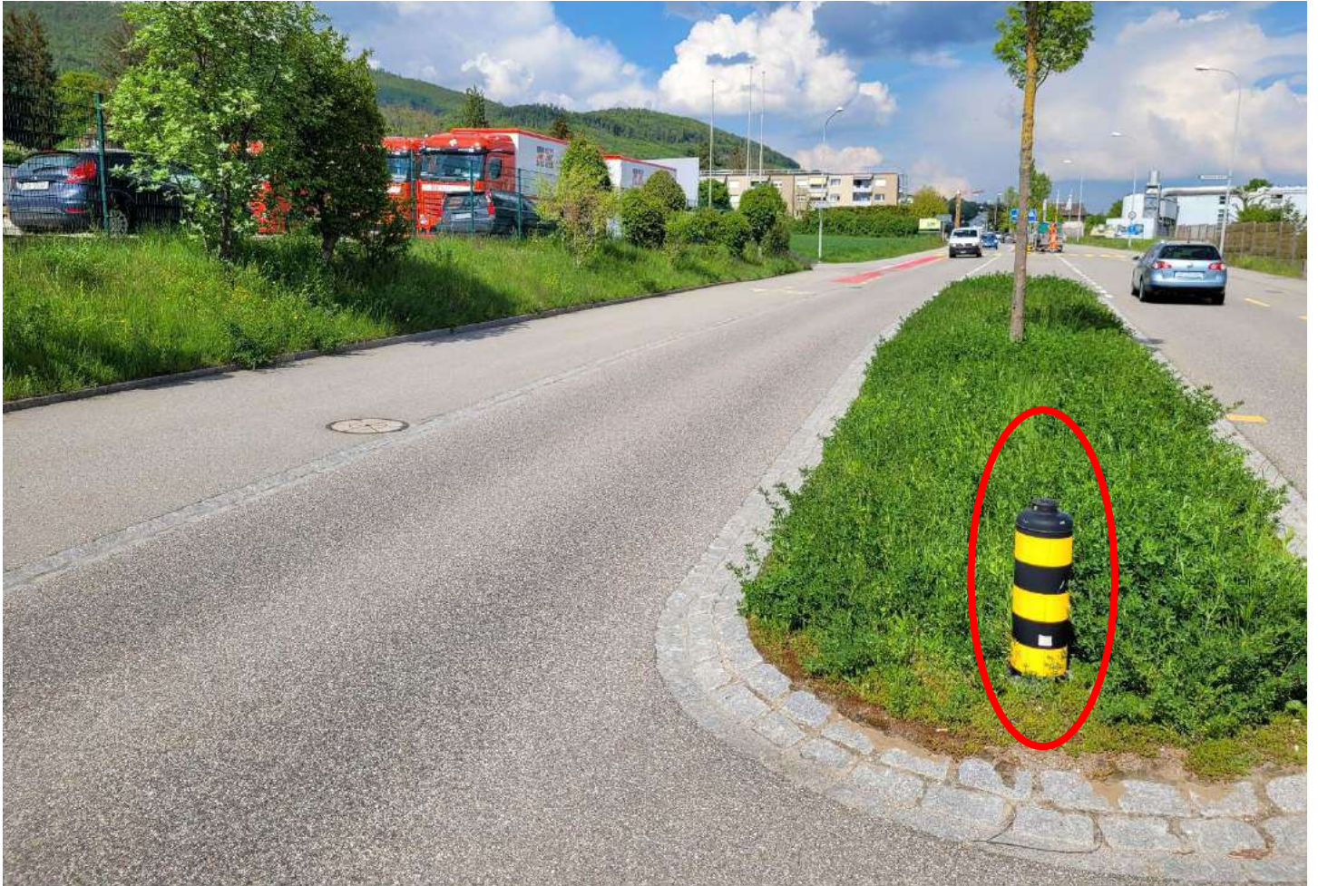
Standort 8 | 47.3375343, 7.8539396; Ri Egerkingen, Bienemaja mit Hilfsrohr (Ro), Akkubetrieb; Kabel lang
