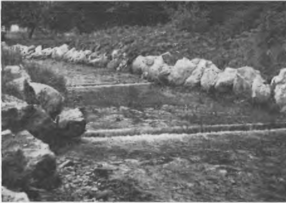
Lüßelverbauung beim Kloster Beinwil.
