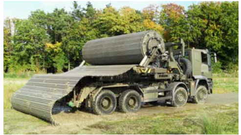
Der Motorfahrer Spezialfahrzeug beim Verlegen einer Abrollstrasse in wenig tragfähigem Gelände
