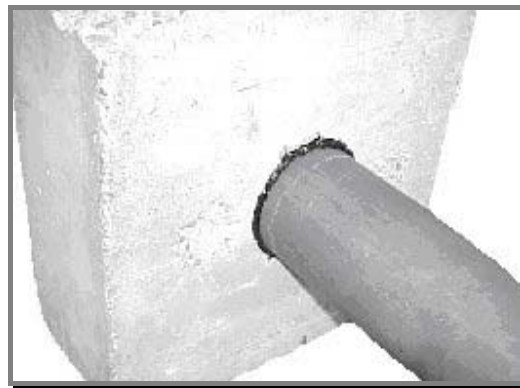
Anwendung mit einer vom BZS genehmigten Dichtmasse
