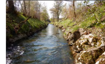
Oe-01a Subigen uha Eisenbahnbrücke
