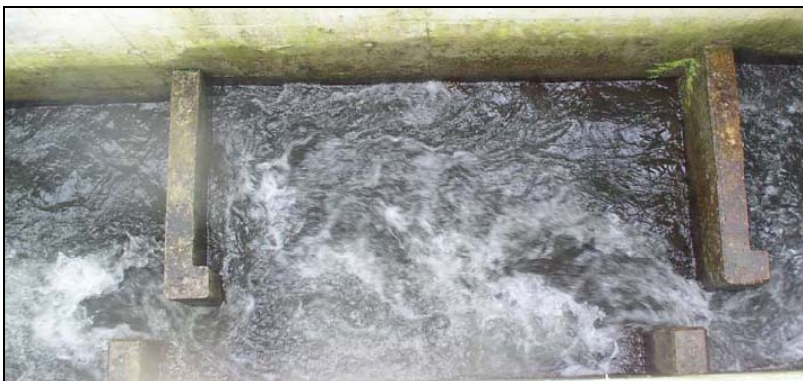
Abb. 4 Vertikalschlitz-Pass Kraftwerk Beznau, FAH beim Wehr, rechtes Ufer. Foto: Ing. Büro Dr. Gebler.
