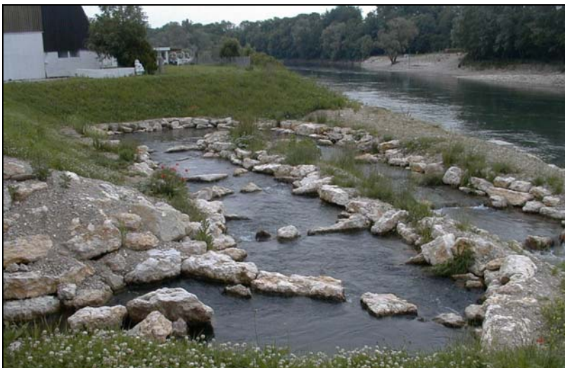
Abb. 3 Raugerinne- Beckenpass Kraftwerk Ruppoldingen. Foto: St. Gerster, Abteilung Jagd und Fischerei des Kantons Solothurn.
