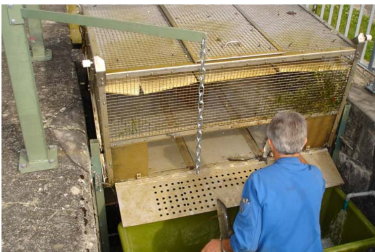
Abb. 6 Reusenleerung beim Kraftwerk Klingnau, die Fische werden von der Reuse in einen Wasserbehälter geleert, auf die Art bestimmt, gezählt und ins Oberwasser entlassen. Seltene Arten oder Fische, welche schwer bestimmbar waren, wurden fotografiert.
