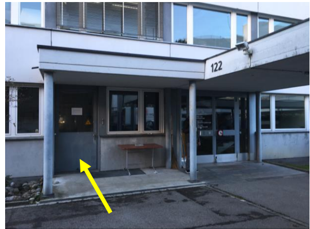
Abb.2. Lokal mit Kühlraum
